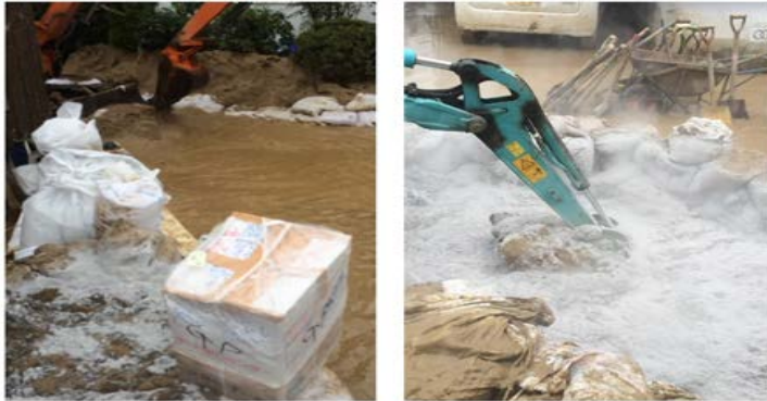
土嚢で仮設プールを作り、スリラー状の土砂を入れセルドロンで攪拌しダンプで搬出
