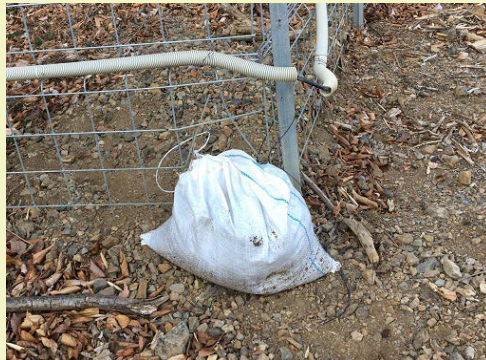
⑥土のう利用 今回は、猪に破られてしまったフェンスの穴を簡易的に塞ぐために土のう袋に入れて活用いたしました。
