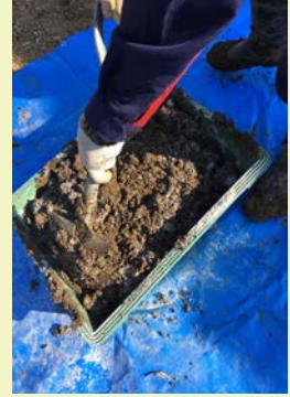
④セルドロン混合 おおよそ75kg/m 3 のセルドロンを添加しました。
