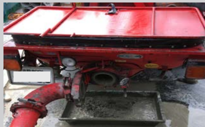
④地下トンネルのモルタル処理
