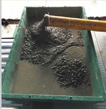
①配管に残った生コン
