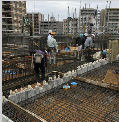
②階上のモルタル処理
