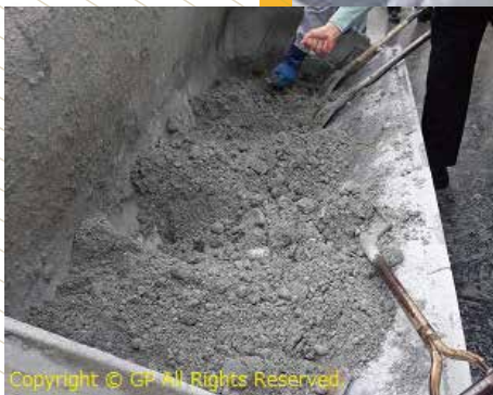
◀残コン碎石専用材38kg添加して攪拌
