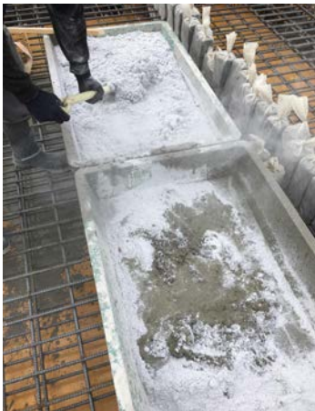
モルタルにセルドロンを入れて攪拌します。
