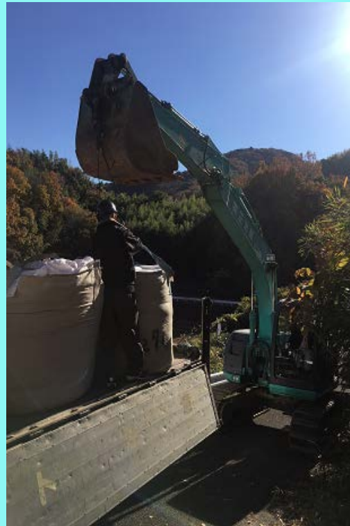
現場での荷下ろしの様子
