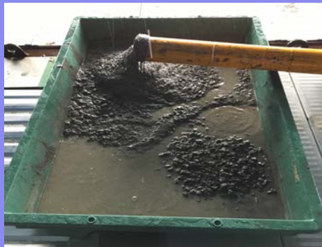
配管に残った生コン
