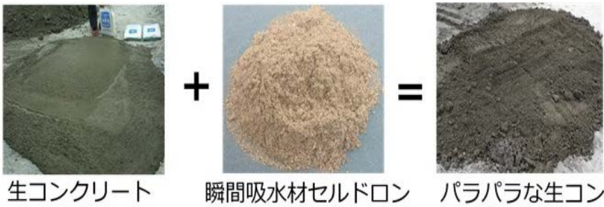
生コンクリートにセルドロンを混ぜた画像
