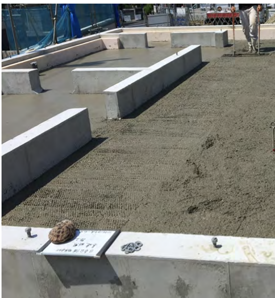
◀ 土間コン施工
